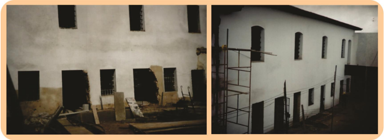
Figura 4 - Restauro externo do antigo Presídio São José Fonte: SECULT, 1999.
